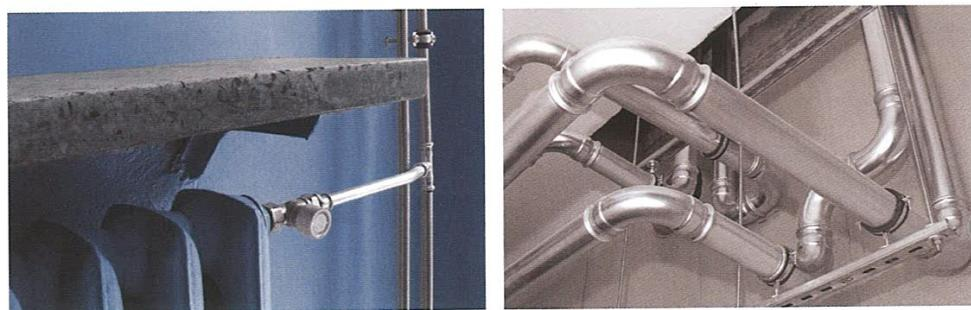
Cevi i fitinzi su zaštićeni od korozije pocinkovanim slojem (Fe/Zn 88) of 8-15 µm, koji se primenjuje na spoljašnjim površinama svih elemenata.
